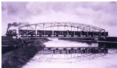
Trambrug met passerende WSM-tram
