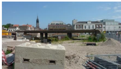
Afbreken spoorviaduct zomer 2015
