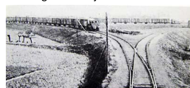
Verkeersknooppunt Maaslandse Dam
