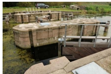
Gerestaureerde sluis in de Poldervaart
