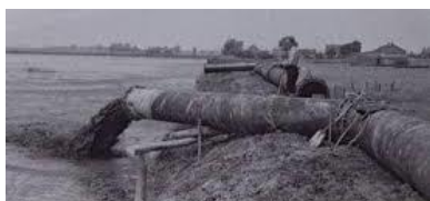
Opspuiten Broekpolder (foto Federatie Broekpolder)
