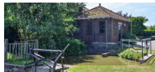
E. Harnasch Poldergemaal
