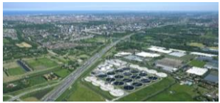
A. Afvalwaterzuiveringsinstallatie Harnaspolder
